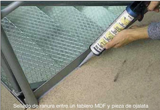
Sellado de ranura entre un tablero MDF y pieza de ojalata
